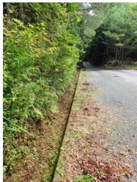
側溝周りの草等刈払い
