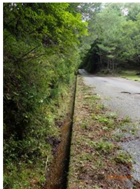
作業後(溝さらい後)
